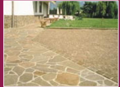
Polygonalplatten und Pflaster ergänzen sich
