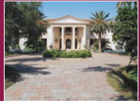
Außengestaltung im öffentlichen Bereich mit geschnittenen Platten
