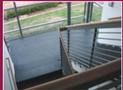
Treppenanlage - Schiefer und Metall ergänzen sich
