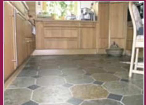
Küchenboden aus Octos Colorado mit Einlegern Negra
